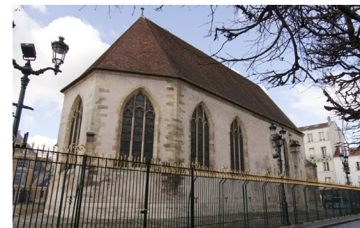
Église de Puteaux - © Fondation du patrimoine
